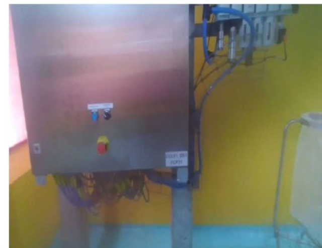
TRAVAUX DE RACCORDEMENT DES EQUIPEMENTS SCHNEIDER (EXTENSION USINE NESTLE YOPOUGON)
