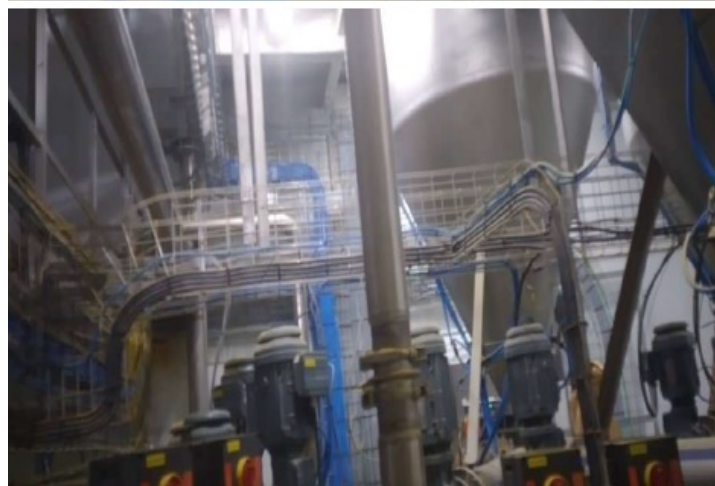
TRAVAUX DE RACCORDEMENT DES EQUIPEMENTS SCHNEIDER (EXTENSION USINE NESTLE YOPOUGON)
